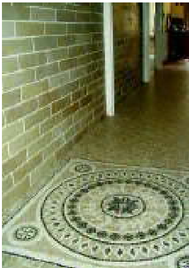
Rejuntado decorativo en todas las situaciones.
